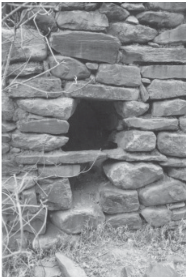
Foto 3. Nichos Trapezoidales en las estructuras
